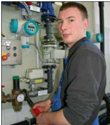
Nur zertifizierte Handwerker dürfen an Hausinstallationen arbeiten Foto: maxpress/mw
