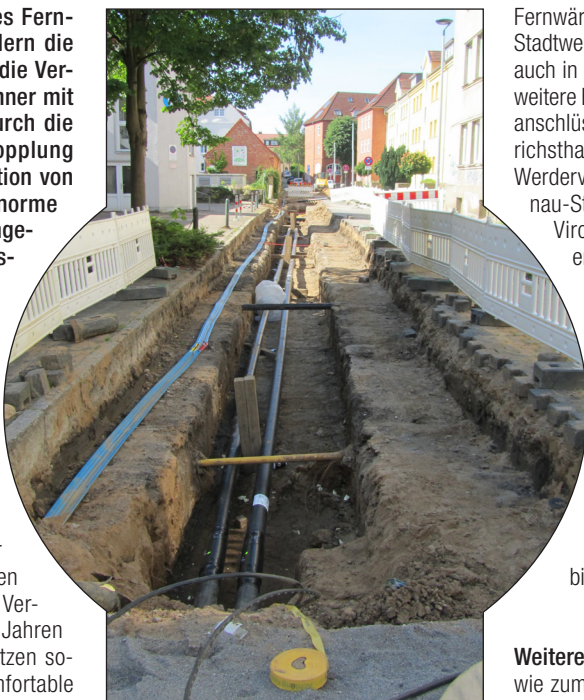
Das Fernwärmenetz der Stadtwerke Schwerin wird auch 2020 weiter ausgebaut Foto: Stadtwerke
