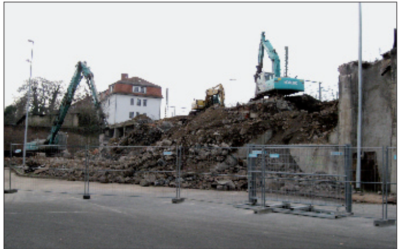
Am direkten Weg zum Hauptbahnhof wird zur Zeit noch gearbeitet
